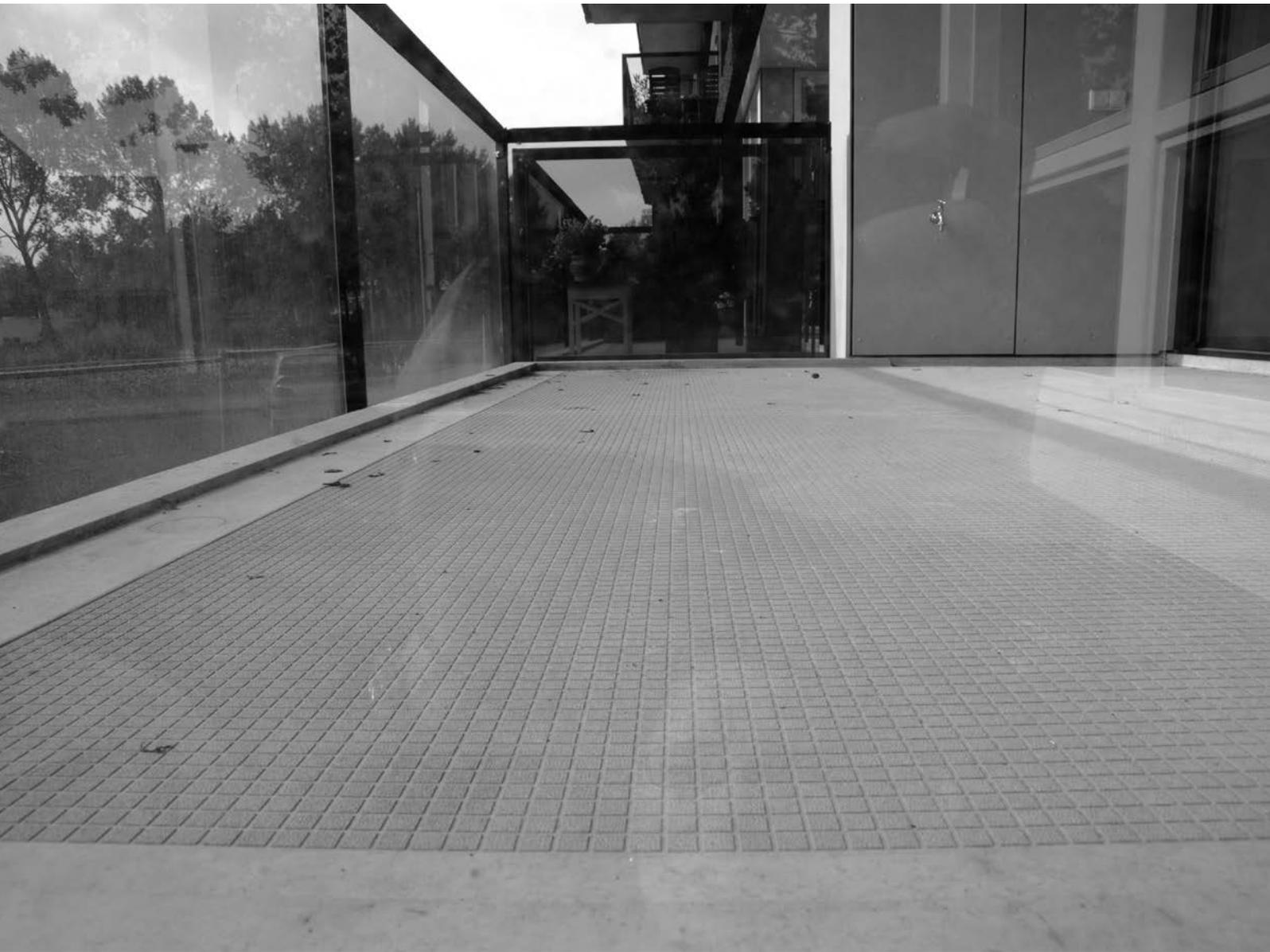
*Betonelemente ohne Nähte in der Oberfläche. Durch die große Länge und die großzügige Breite der GIAN® -Strukturmatrize(n) ist die Betonoberfläche nahezu nahtlos.*
